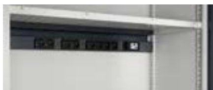
Applicazione canaletta elettrica sulla parte inferiore del piano-pannello forato
